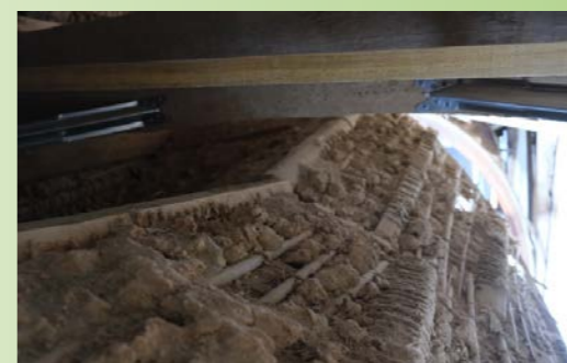
天井の裏側は竹小舞土壁が確認できる
