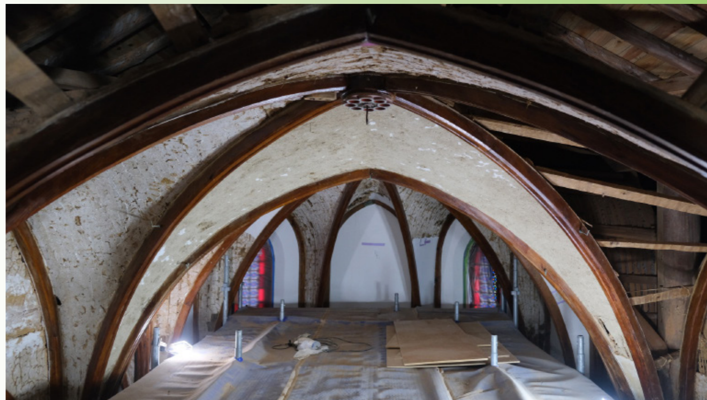
美しいアーチ状のリブ・ヴォールト天井の一部が解体された屋内（令和6年1月時点）
