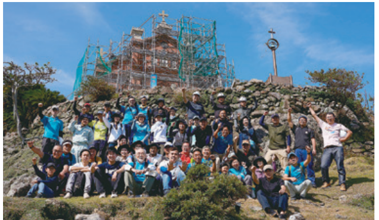
保存修理工事中の教会前で集合写真
