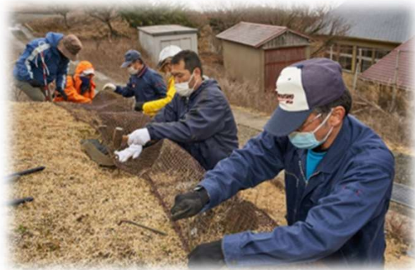
(集落跡の石垣保護のためのネット張り ハンマーでアンカーを打ち込み網を固定します)
