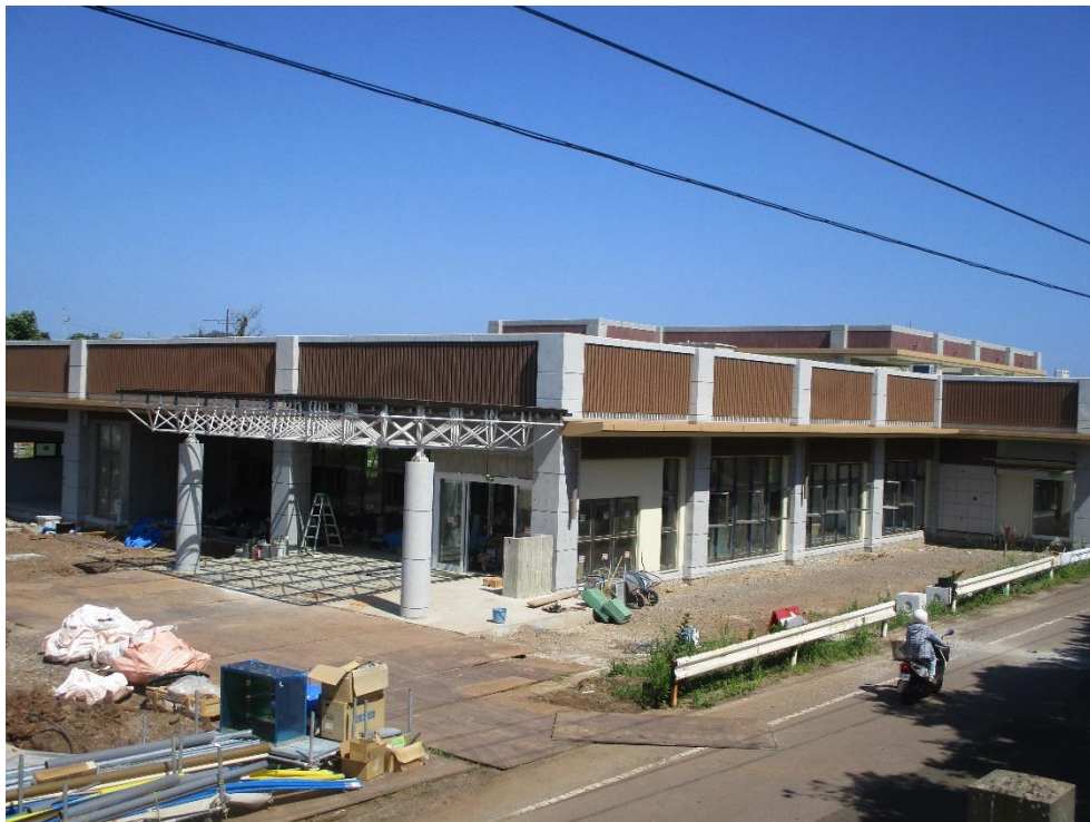
(建設中の小値賀診療所)
