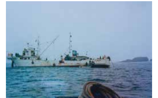
大島沖電話線布設作業
