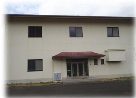
笛吹浄化センター
