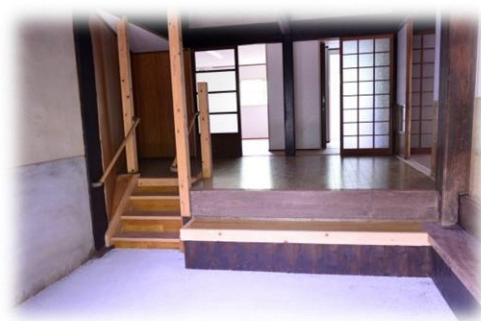
定住促進住宅改修例
