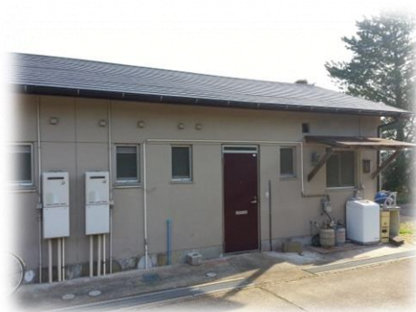
屋根を改修した町営住宅
